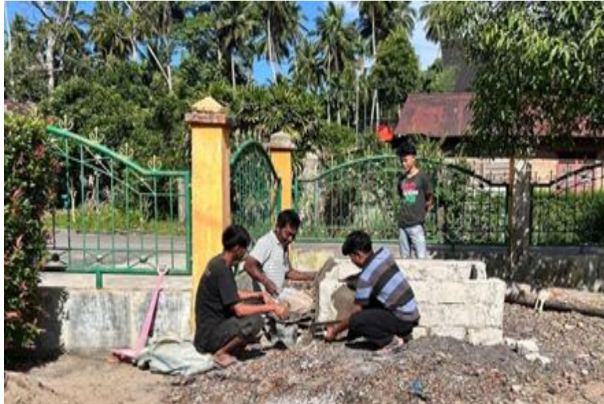
Gambar 3. Proses Penyusunan Batako
