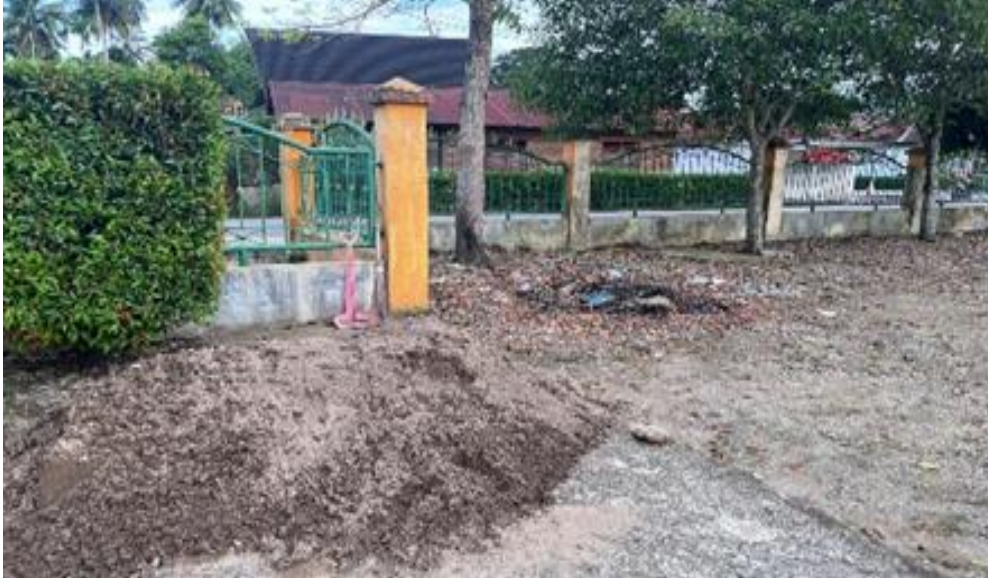
Gambar 1. Lokasi Pembangunan Tong Sampah
